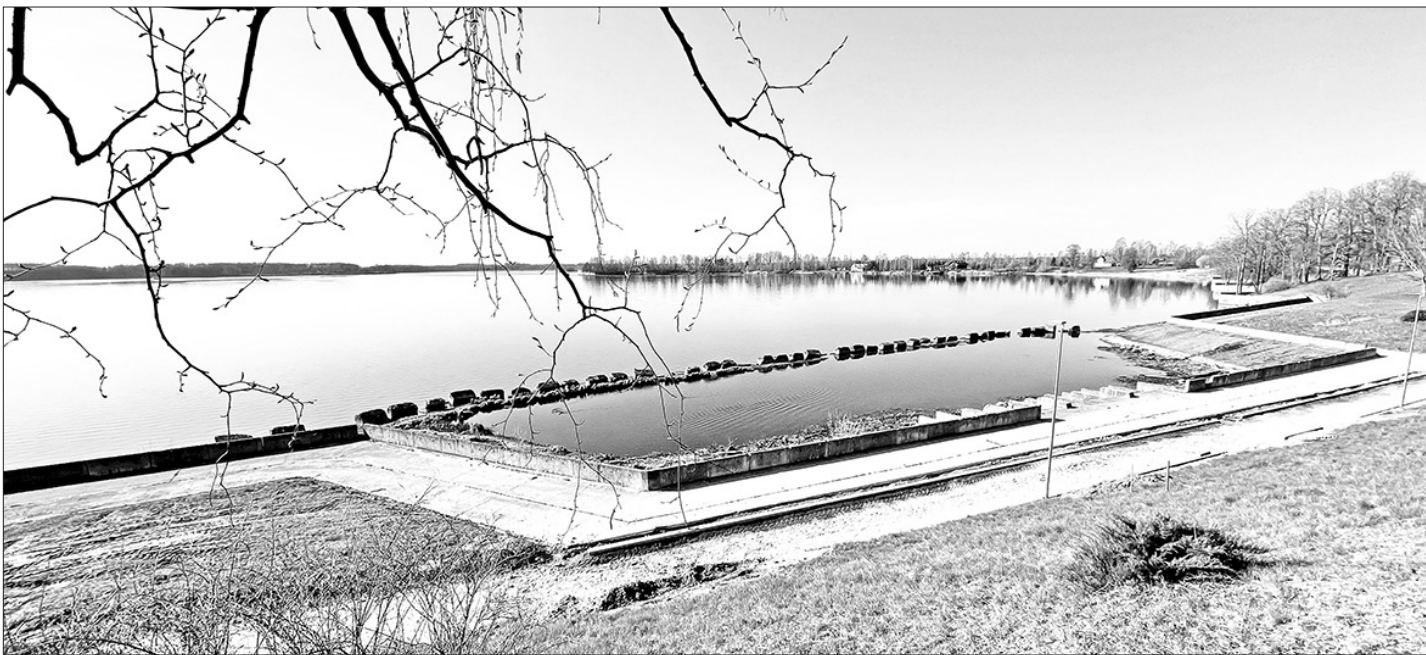
Lai uzlabotu ainavu un novērstu sanesumu uzkrāšanos, šopavas ar uzsāka betona bluķu izņemšanu no Daugavas ūdenskrātuves.
