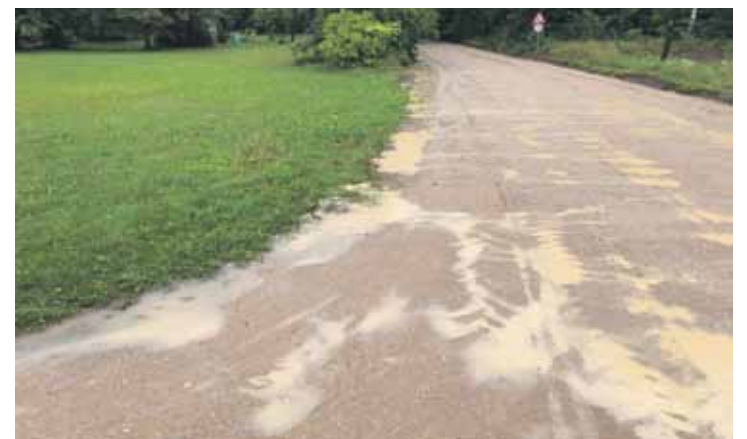
Remontējamā ceļa posmā pēc pirmajām lietusgāzēm vietām ceļš izskalots un vietām veidojās peļķes.
