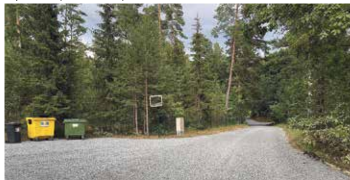
Pašvaldības ceļa 80-92-C12 Murjāni—Beltes (2,2.–4,25. kilometrs) divkārtu virsmas apstrāde. Līguma kopsumma (bez 21% PVN) ir 98 777,00 eiro. Foto: Laura Breimane-Tutāne
