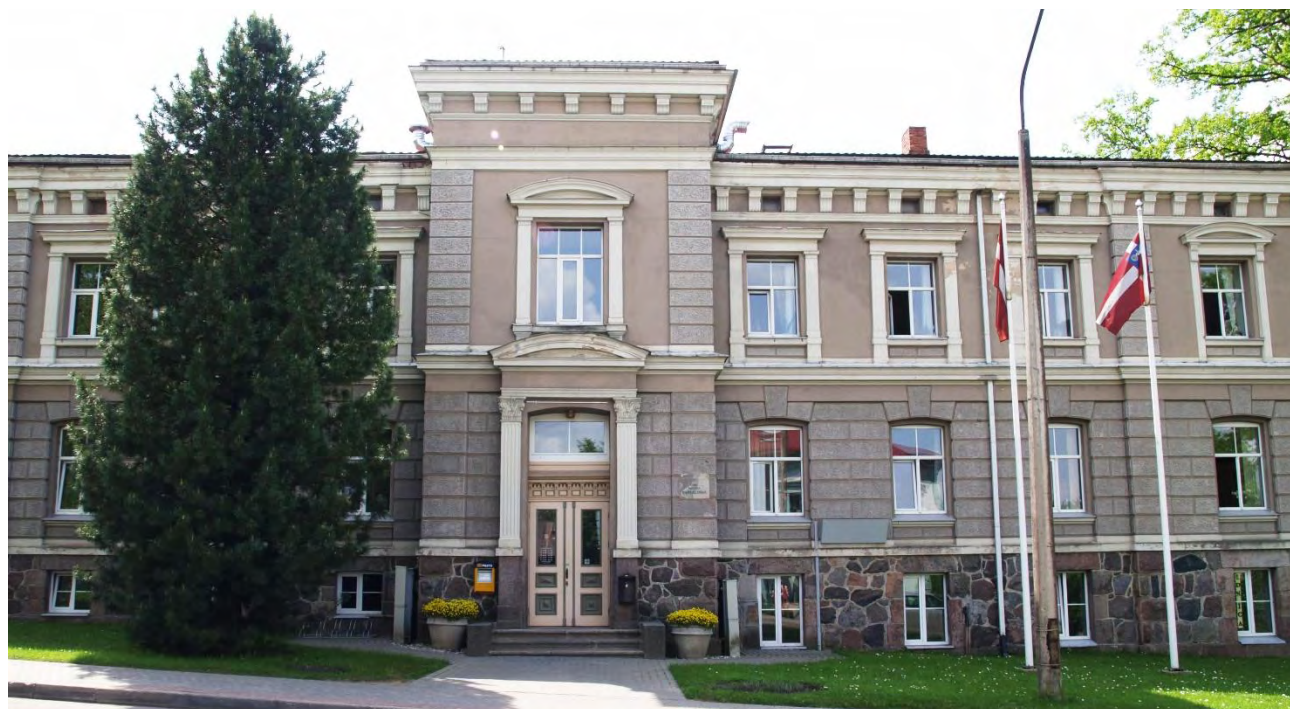
Cēsu novada pašvaldības administrācijas ēka Cēsis, Bērzaines ielā 5.
