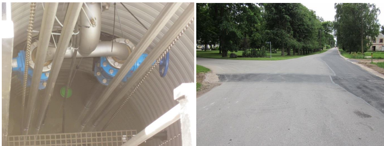
3.1.att.; 3.2.att. Dziļurbuma aka un A.Lerha Puškaiša bulvārī izbūvēti tīkli
