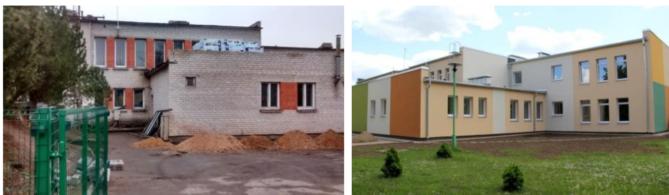
3.3.att.; 3.4.att. Džūkstes bērnudārza ēka pirms un pēc siltināšanas darbiem
