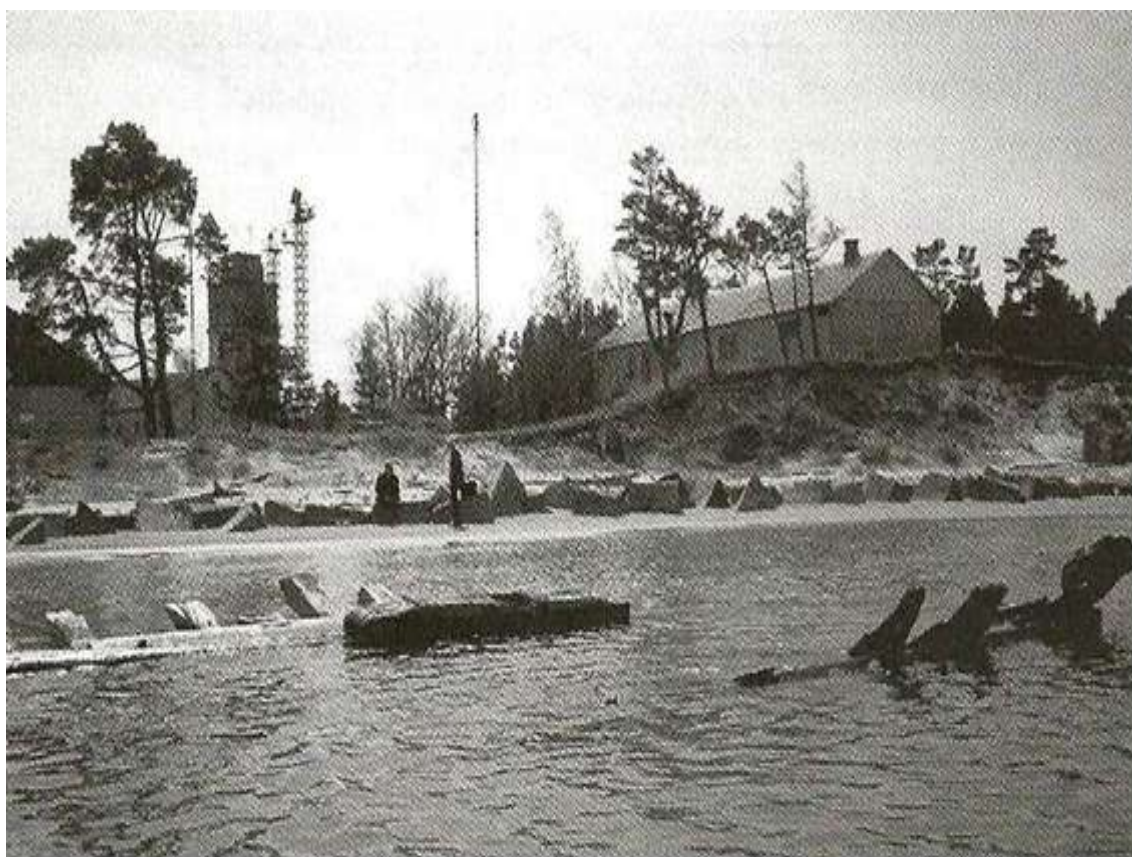
6.attēls. Skats uz robežapsardzes posteņa ēkām Kolkasragā, priekšplānā vētras izskalotais „malkas jancis”, 1996.g. (avots: Latvijas žurniecības gadagrāmata 2007, 427.lpp.)
