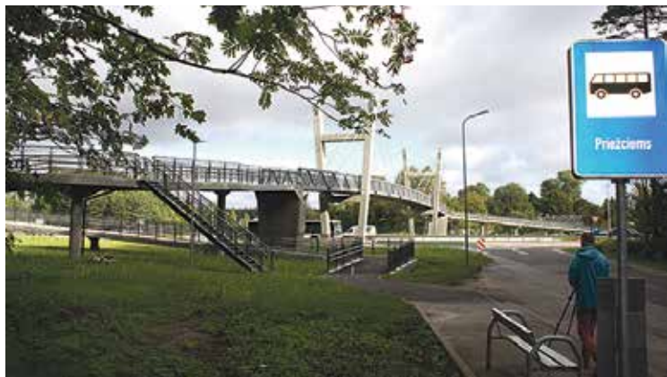
Uzņēmuma „Latvijas valsts ceļi” šogad uzbūvētais gājēju un velosipēdistu tilts pār Jūrmalas šoseju.
