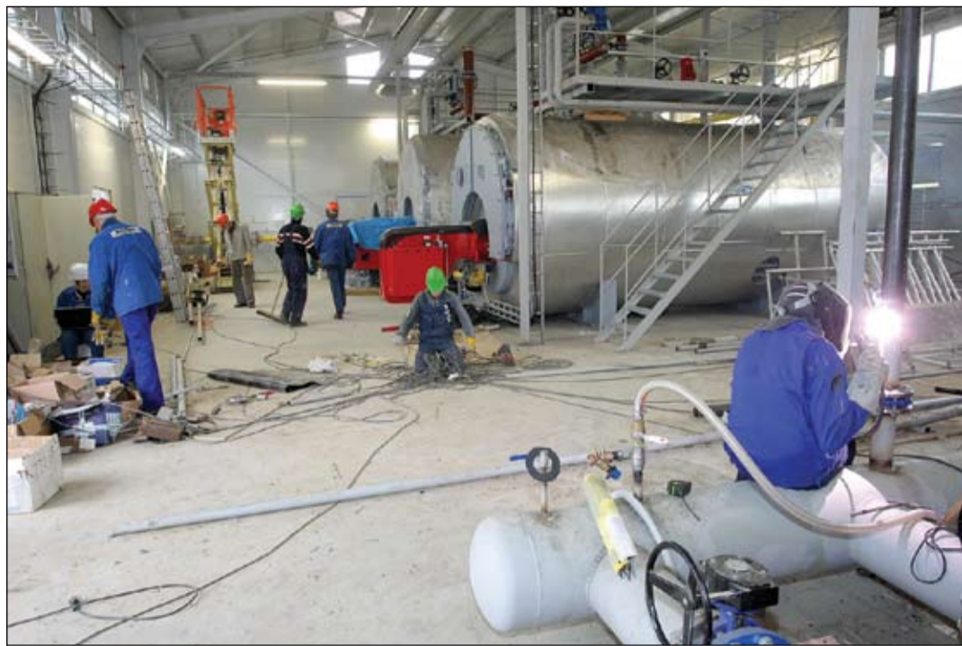
Pirmdien jaunās katlumājas būvnieki no uzņēmuma «Filter» veica pēdējos priekšdarbus un iekārtu pārbaudi, lai otrdienas pēcpusdienā jaunais siltuma avots sāktu ražot siltumu un karsto ūdeni Pārlielupes patērētājiem.
