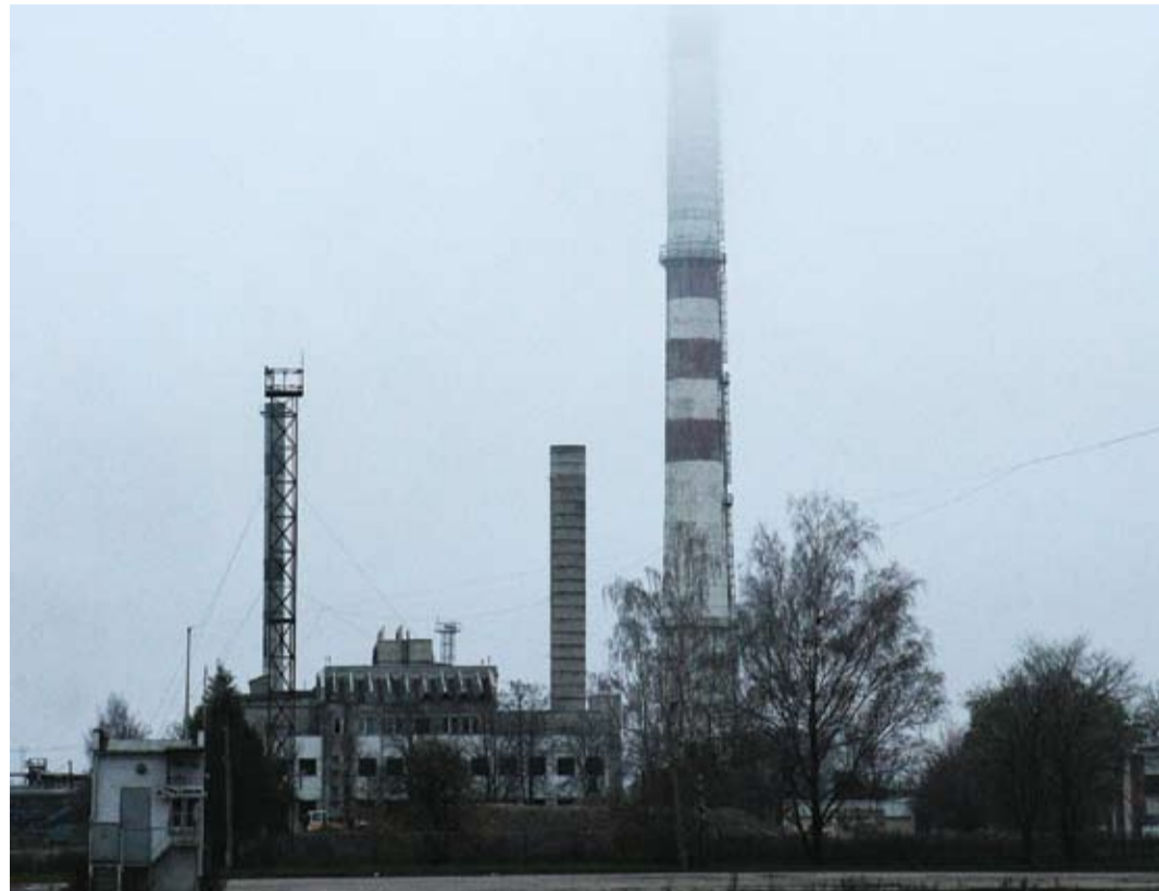
Jau šomēnes būs skaidrs, kā visdrošāk un ekonomiski izdevīgāk nojaukt cukurfabrikas skursteni.
