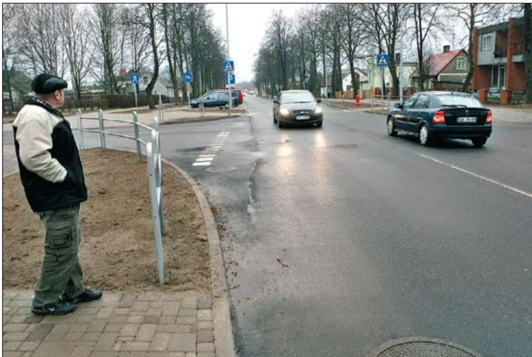
Kaut arī satiksme Brīvības bulvārī ir atjaunota, objekts pēc rekonstrukcijas vēl nav pieņemts – pašlaik, tehnoloģiskās pauzes laikā, speciālisti apzina paveiktā kvalitāti, lai darbu veicējs varētu novērst atklātos defektus. Foto: Ivars Veiliņš
