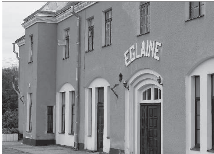
В настоящее время железнодорожная станция Эглайне используется только для грузовых поездов.
