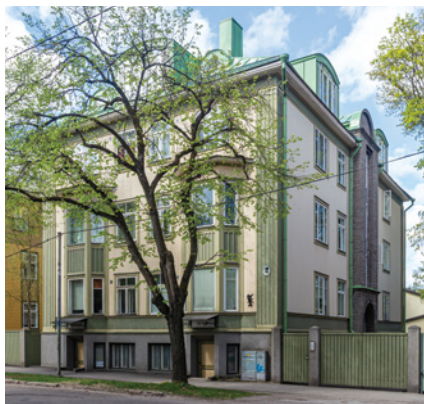
22. attēls. Trīsstāvu daudzdzīvokļu ēka Tallinā, Laulupeo ielā 7 (2021).
