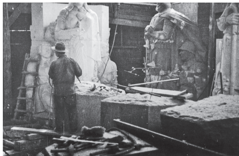
Akmens blūku apstrāde ar pneimatisko kalšanu. 1930. gadu sākums // Avots: LNA Latvijas Valsts arhīvs
