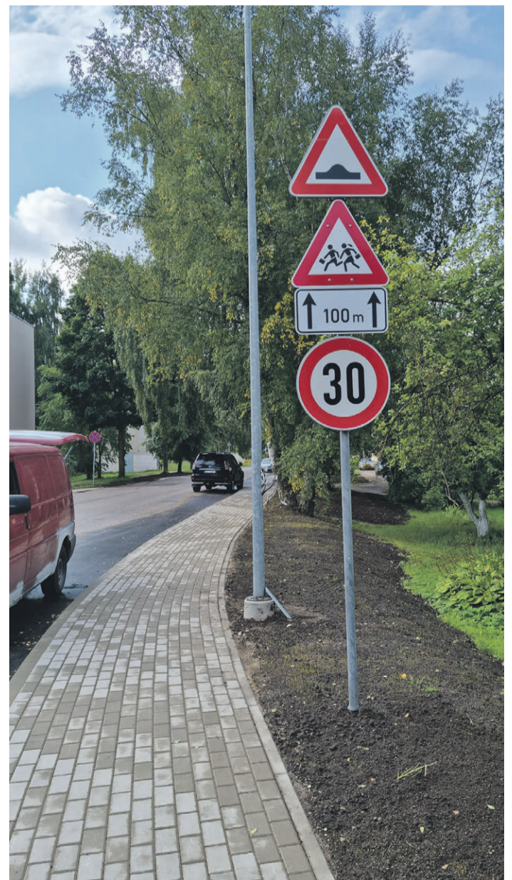
Izbūvēta gājēju ietve Skolas ielā, Saulkrastos.
