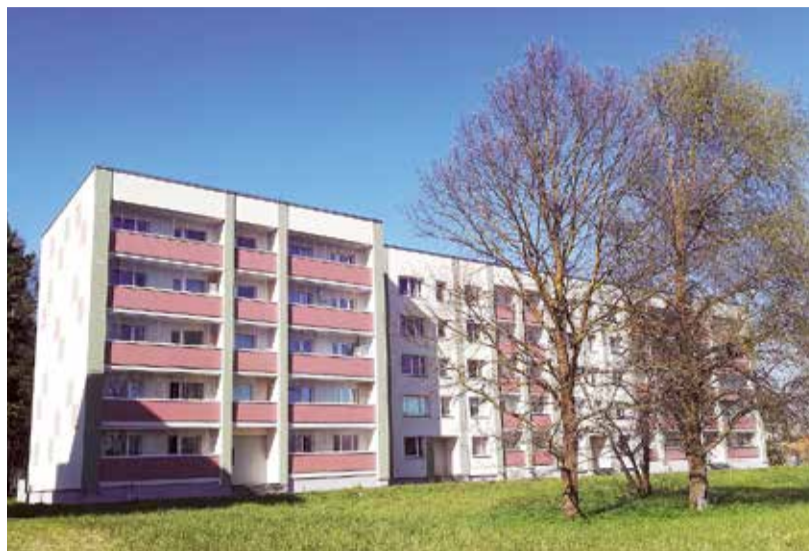
Māja Meža ielā 7 ir viena no tām, kas ar ALTUM līdzfinansējumu ir kļuvusi siltāka un skaistāka.
