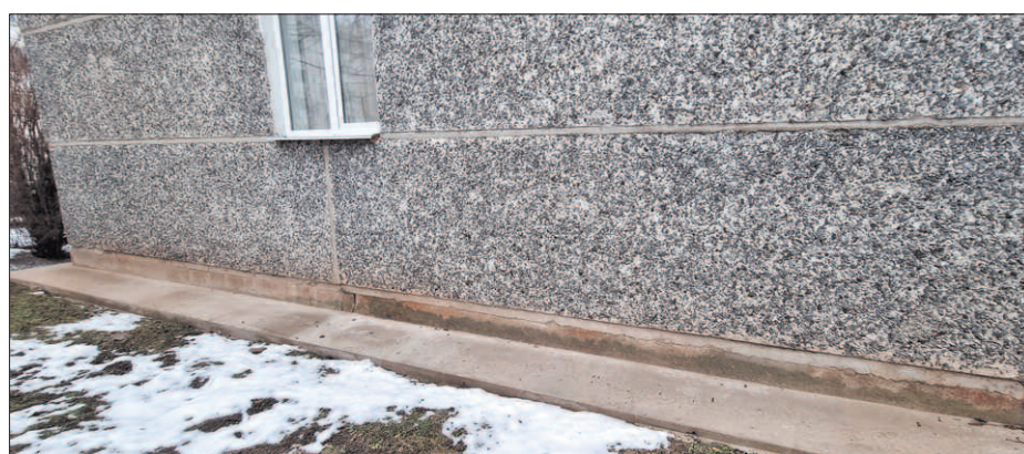
Jelgavas iela 2 – pamatu apmales remonts
