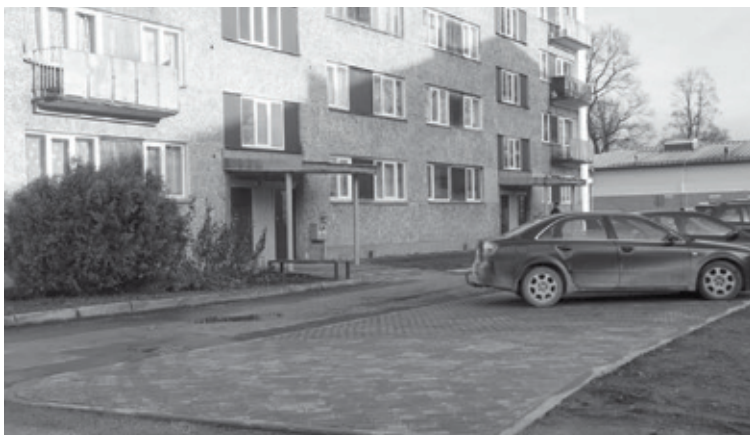
Pils ielā 38 izbūvēts auto stāvlaukums
