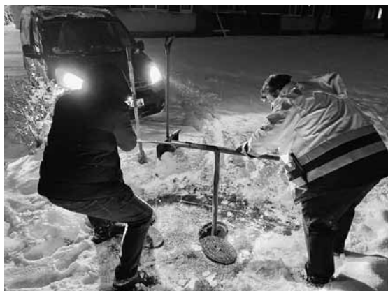
Kuldīgas siltumtīklu darbinieki griež ciet maģistrāles ventilus, meklējot noplūdes rajonus.
