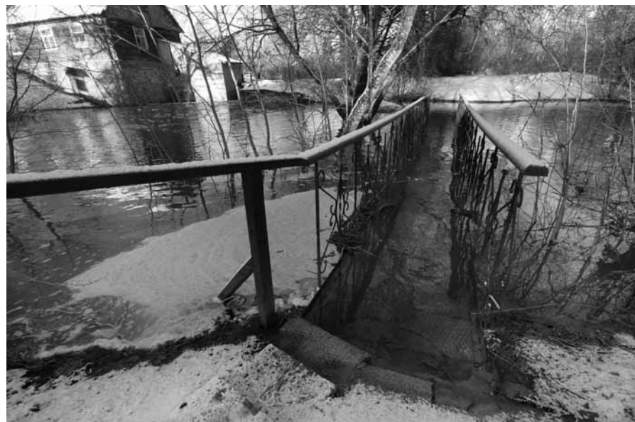
Viens no applūdušajiem ir metāla tiltiņš uz betona balstiem. Tam, visticamāk, nekas nevar būt nodarīts. Kad ūdens līmenis nokritīsies, jāskatās, kas būs ar koka tiltiņu.
