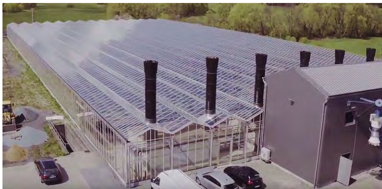
48. attēls. Segti siltumnīcas tipa notekūdeņu dūņu žāvēšanas lauki 34
