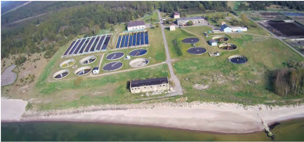
7. attēls. Notekūdeņu attīrīšanas iekārtas Liepājā ar projektēto jaudu 55 000 m 3 /dnn, SIA „Liepājas ūdens” arhīvs
