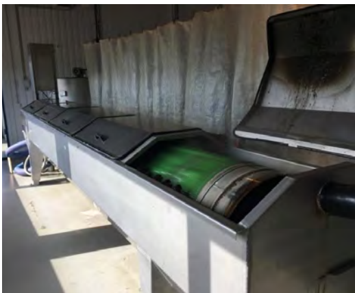
32. attēls. Notekūdeņu dūņu blīvētājs – rotējošs siets
