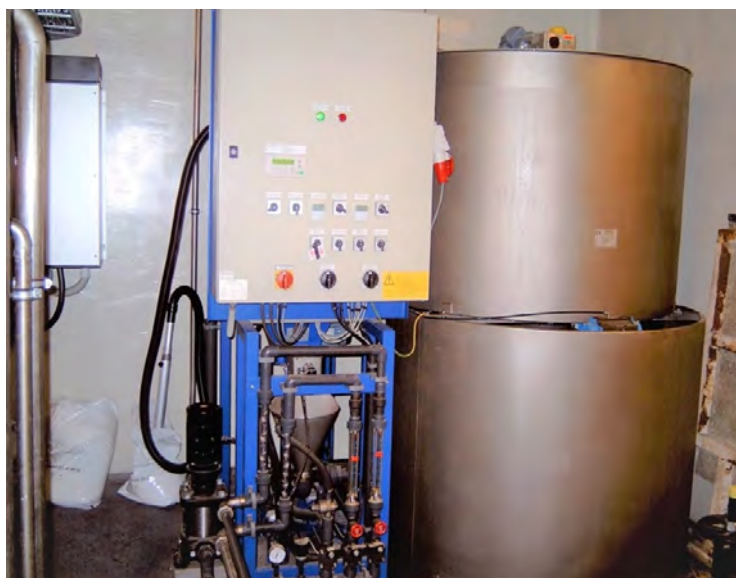
26. attēls. Polimēra sagatavošanas iekārta Liepājas NAI 21
