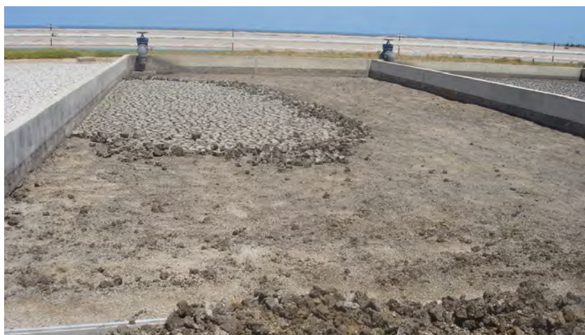
45. attēls. Atklāti notekūdeņu dūņu žāvēšanas lauki 32
