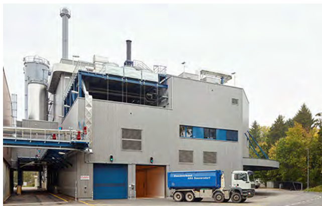
60. attēls. Notekūdeņu dūņu dedzināšanas iekārta Cīrihes kantonā Šveicē 51
