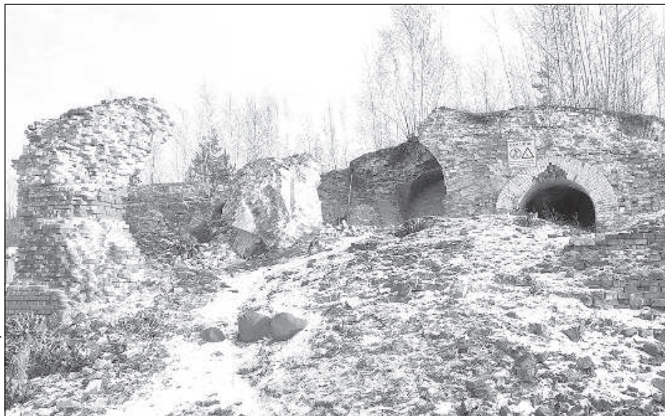
Один из ярчайших примеров неостоянства в крепости – руины 5-го редюита. Главная арка обрушилась в 2021 году.
