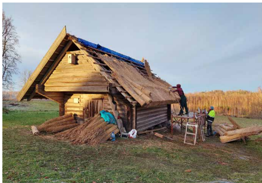
Notiek niedru jumta klāšanas darbi.
