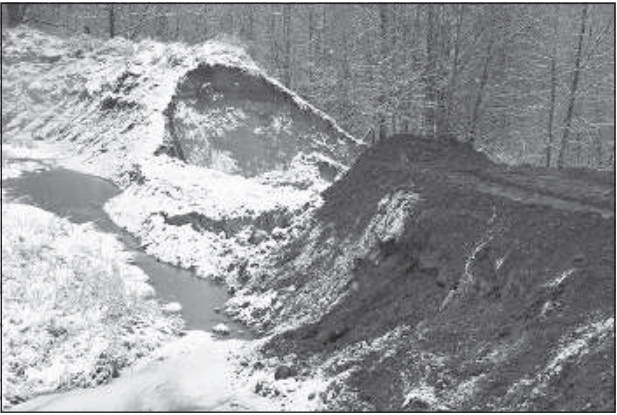
Размытый вал на иловом поле в Крыжах в конце прошлого года.
