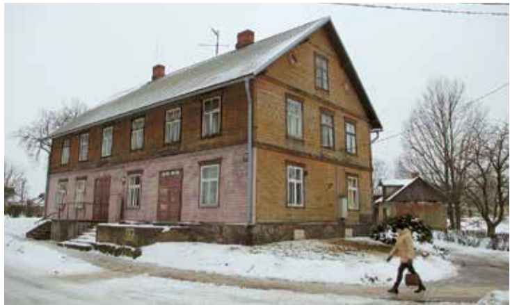
Ēka Lielā iela 12, Staicelē, tagad ir tukša un pēc ugunsgrēka gaida atjaunošanu.
