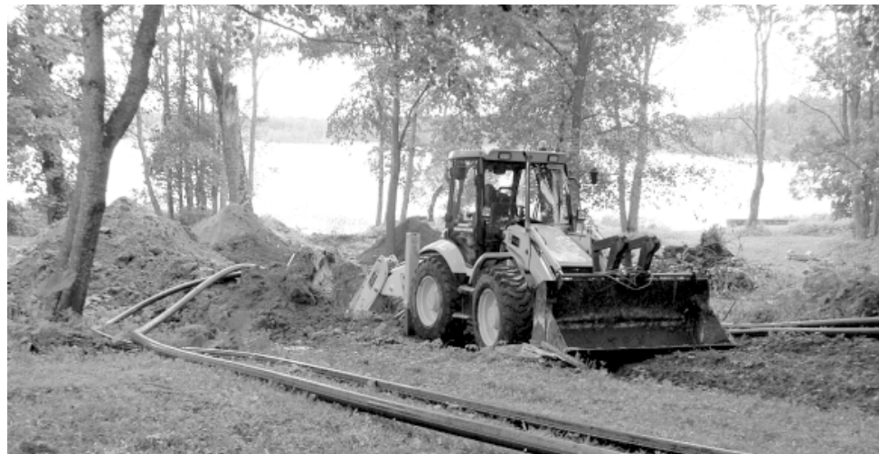
Zemē tiek ieraktas caurules, pa kurā zemes siltums no Katvaru ezera tiks aizvadīts uz skolas un saimniecības ēku
