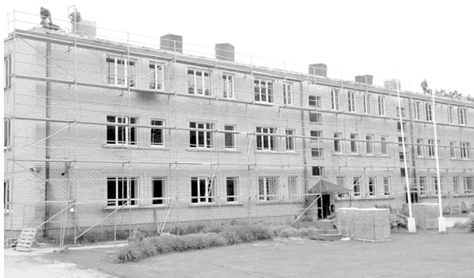
Lai veiktu siltināšanu un 4. stāva izbūvi, Katvaru speciālās internātpamatskolas ēka apjota ar stalažām
