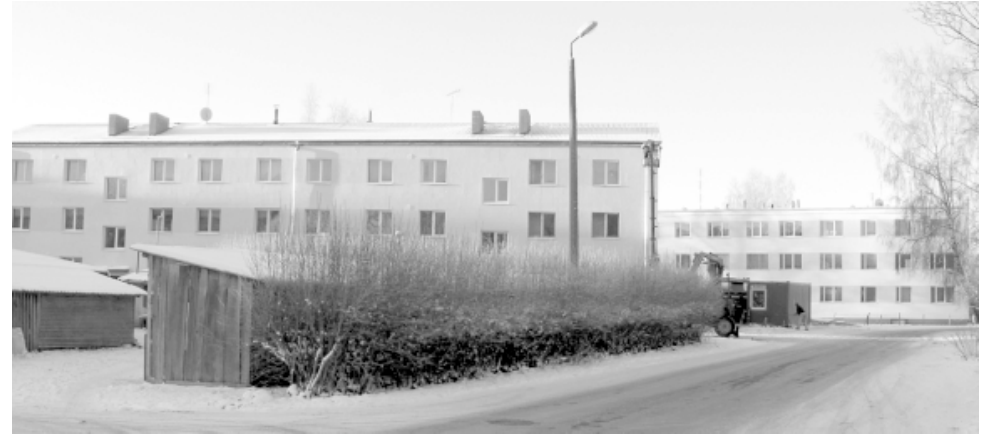
Nosiltinātais Ozolaines daudzdzīvokļu nams Ābeļu ielā 9. Aizmugurē māja Ābeļu ielā 11, kur siltināšanas projekts ar ERAF atbalstu īstenots pērn
