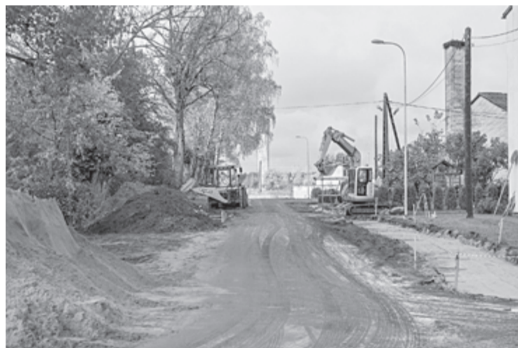
Skultes pagasta Mandegu ciemā satikušies divi projekti - vienā ielas pusē ūdenssaimniecības projektā tiek ieguldīta kanalizācijas caurule, otrā top gājēju ceļiņš
