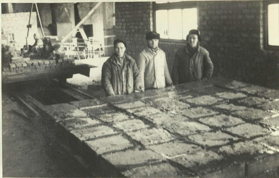
Футеровка пола печной туннельной вагонетки из блоков фосфатного бетона Ф-41, склеянных фосфатным клеем на АХЭС.
