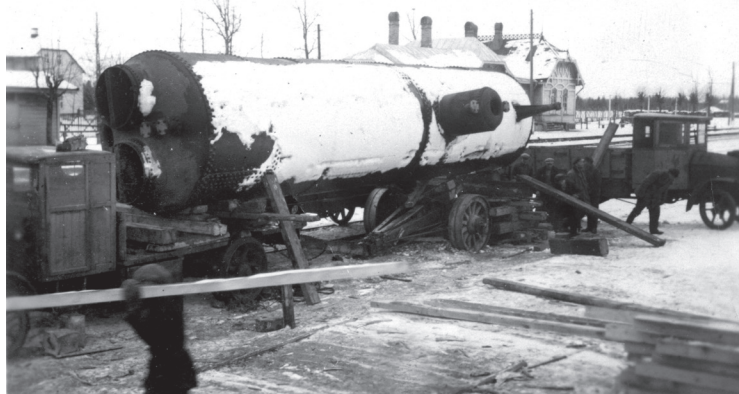
Fotogrāfijā redzams, ar kādām grūtībām tajos laikos notiek pa dzelzceļu atvestā Lankašīr-tipa tvaika katla pārvešana no Līgatnes stacijas uz Līgatnes papīra fabriku.
