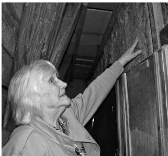
Zelma Vazdiķe rāda senās kapitālsienas, kas no ārpuses apšūtas ar dēļiem. Tāpat kā pamati tās esot saglabājušās no mājas celšanas laika 1670. gadā.
