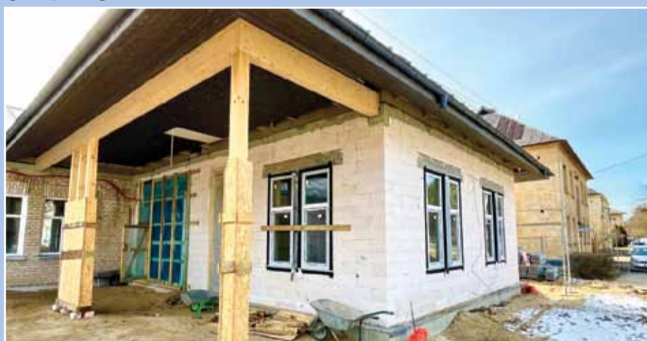
Ulbrokas ambulances ēkas pārbūve. Projekta izmaksas 0,8 milj. EUR. Būvdarbu veicējs SIA "Re Re Meistari".
