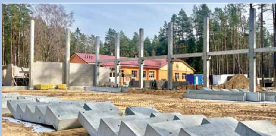
Stopiņu pamatskolas piebūves būvniecība. Projekta izmaksas 3,4 milj. EUR. Būvdarbu veicējs SIA "LC Būve".
