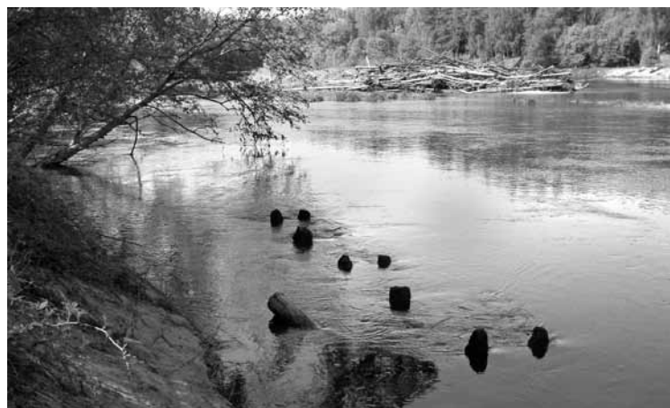
Muižnieku tilts ticis būvēts uz koka pāļiem, kuri vēl tagad – pēc 97 gadiem – labi redzami Gaujā.
