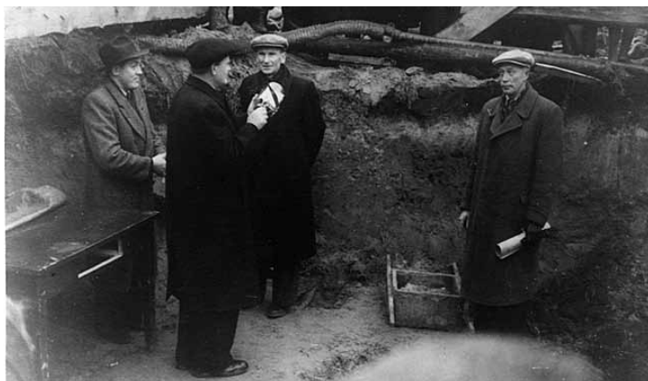
Pamatakmens iemūrēšana Līgatnes vidusskolai.
