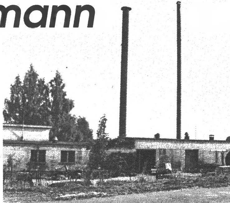
● Saulkalnes katlu mājā jau notiek rekonstrukcijas darbi.
