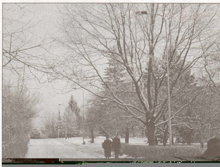
Jaunizbūvētā apgaismes līnija Ziemeļu ielā.
