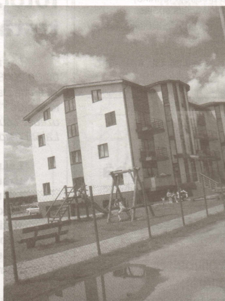
Daudzīvokļu māja Malienas ielā 2
