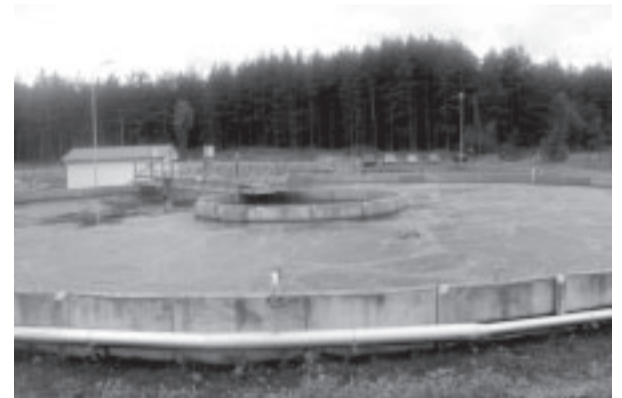
Jaunās rekonstruētās notekūdeņu attīrīšanas iekārtas
