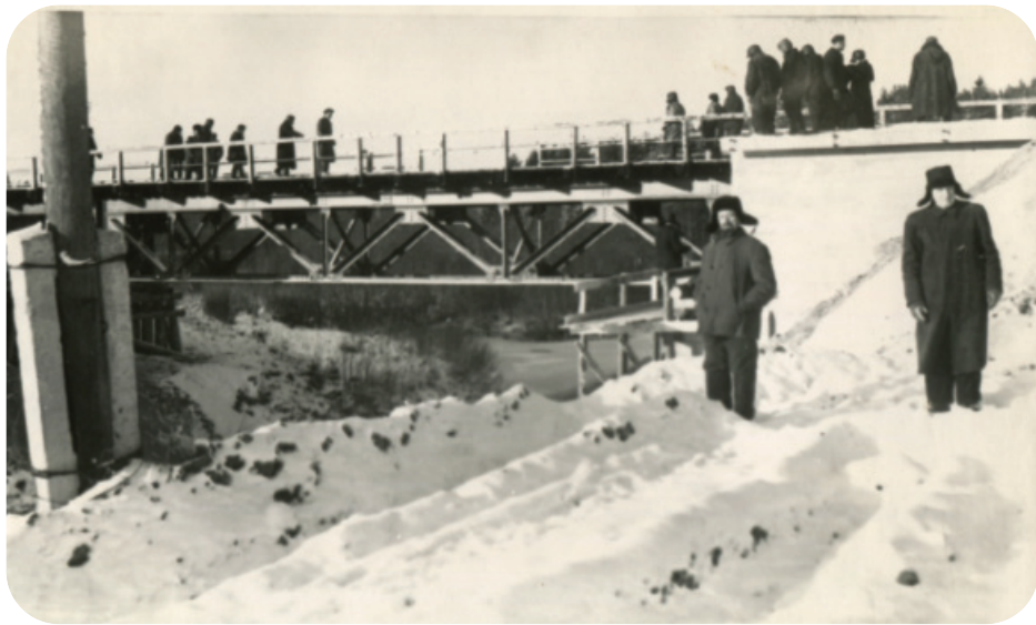
Dzelzceļa Ieriķi - Gulbene tilta pār Amatu pārbūve - ap 1960. gadu
