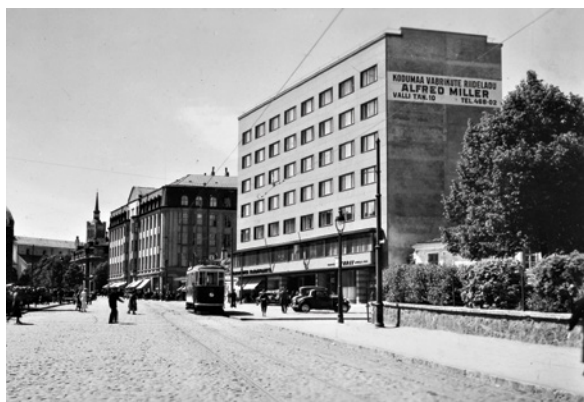
12. attēls. Jaan Urla daudzdzīvokļu māja Pärnu ceļš 6, Tallinā (1933).
