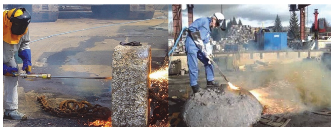
9.2. attēls. Atveres griešana betona masīvā, izmantojot skābekļa-pulvera šķēpu.
