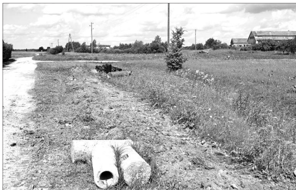
Dārza ielā būs daļēji atjaunota notekūdeņu kanalizācija.
