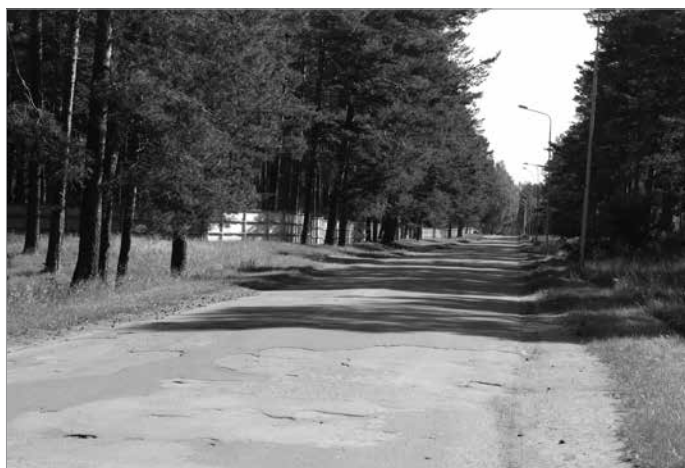
Pirms ceļa rekonstrukcijas
