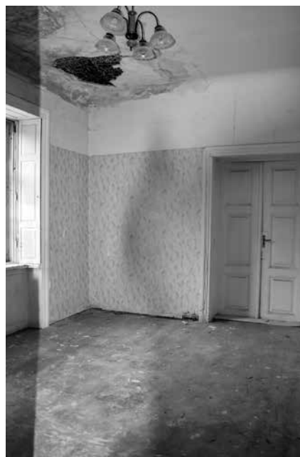
Telpa pirms remonta.
