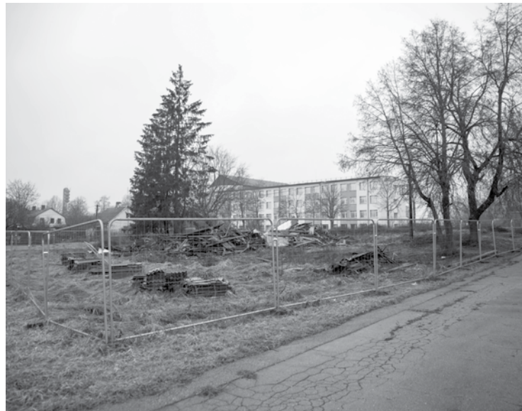
Vietā, kur Liepājas ielā Skrundā taps automazgātava, ēkas ir nojauktas, taču šis darbs vēl nav pabeigts.
