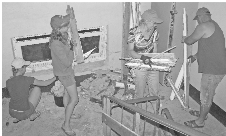
■ Общими усилиями приводится в порядок лестничное помещение после смены окон.
