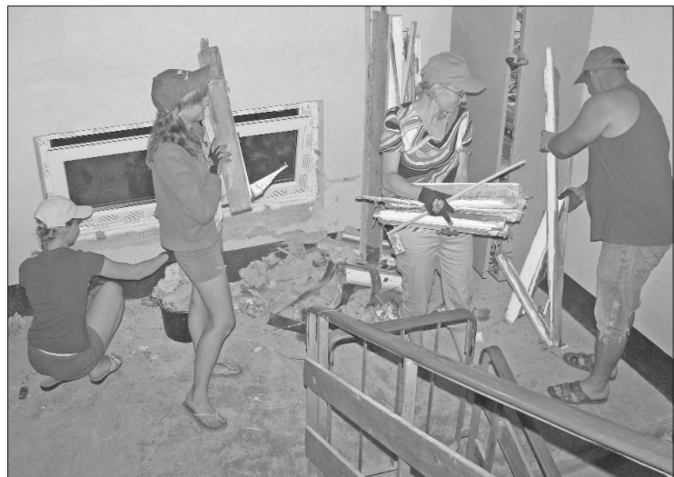
■ Kopīgiem spēkiem tiek sakārtota kāpņu telpa pēc logu nomainīšanas
