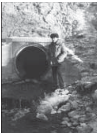
Pie izveidotās lielgabarīta caurtekas Vītes-Viršukalna ceļā.
