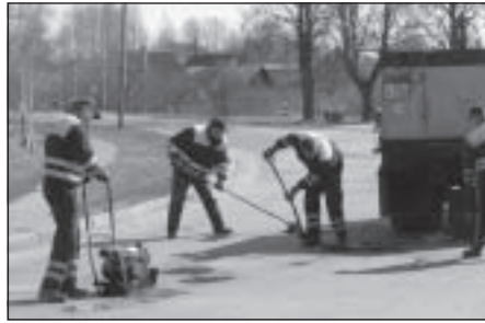
Asfalta bedrīšu nolīdzināšana uz valsts nozīmes ceļiem notika 19. aprīlī.
