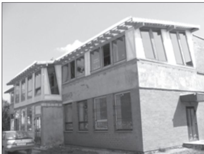
Pirts ēkas fasāde ieguvusi jaunu, pavisam citādāku izskatu.
