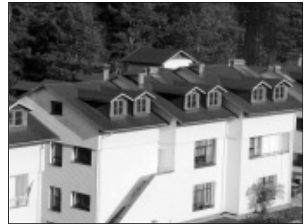
Sociālās aprūpēs māja „Gauja”, Inčukalnā. Kolektori uzstādīti 2009. gadā.
