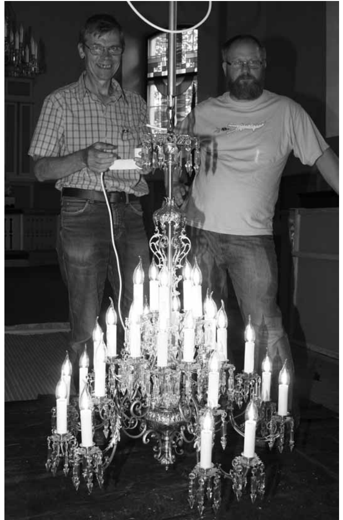
Vēsturisks mirklis - jaunā lustra pirms pacelšanas ieslēgta, lai pārbaudītu, vai deg visas spuldzes! Restaurators Jānis Līdaka (no lab.) un elektriķis Aldis Lūsis
