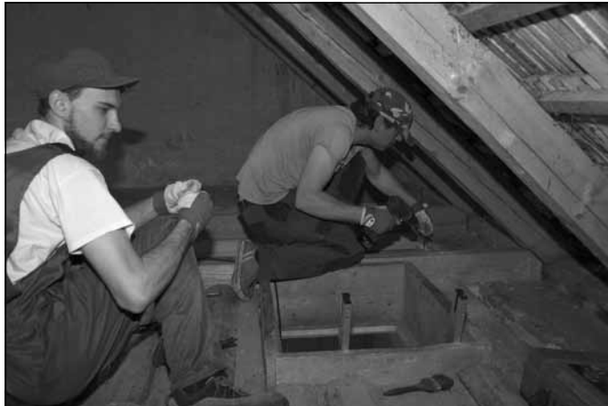
Restaurators Edgars Melnis (no lab.) ar palīgu Albertu Krūzi veic baznīcas sakristejas jumta siju pastiprināšanu
