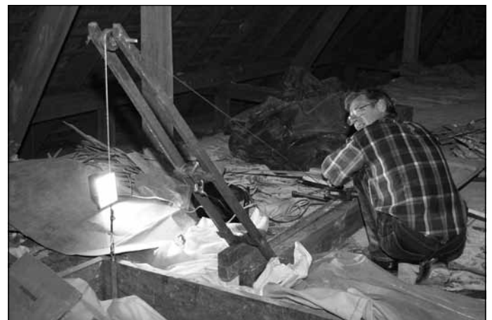
Mālpilietis Aldis Lūsis baznīcas bēniņos ar paša uzkonstruēto vinču nolaiž veco lustru
